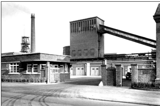
Eingang Autohof Schacht 1/2/6
